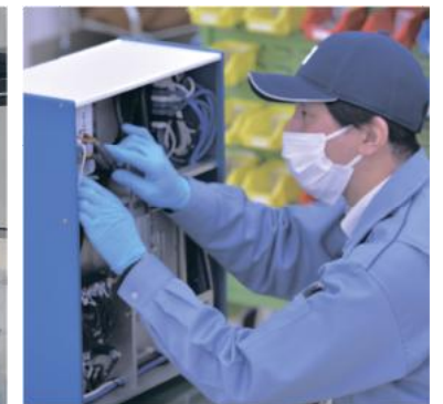
検査装置配線
