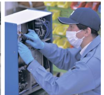
検査装置配線
