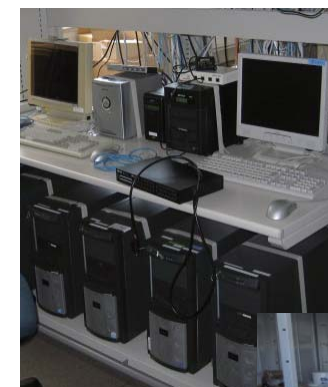
◀ 地震発生時の転倒等によりデータが損なわれることのないよう、サーバーを耐震ベルトで固定しています。
